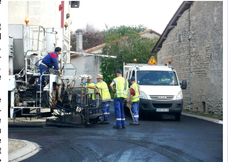
L'entreprise Eurovia en plein travail dans le bourg !
