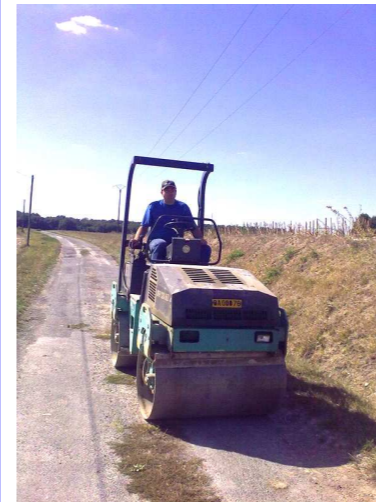
Le rouleau compresseur, indispensable pour bien compacter le bitume.
